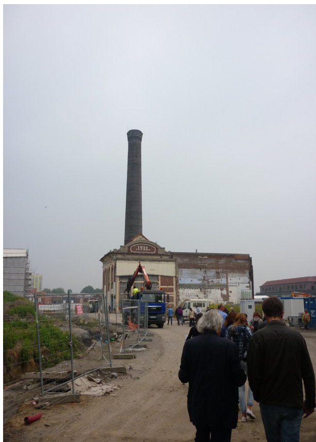
La chaufferie, emblème industriel. (c) Mathilde Wybo.
