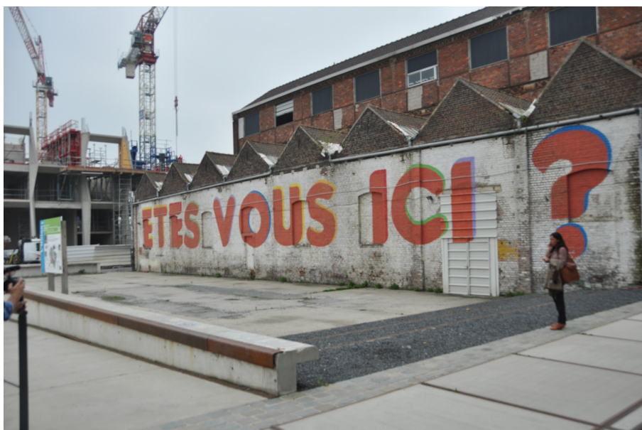
Un ancien magasin de stockage de laine. (c) Claudio Broitman.
